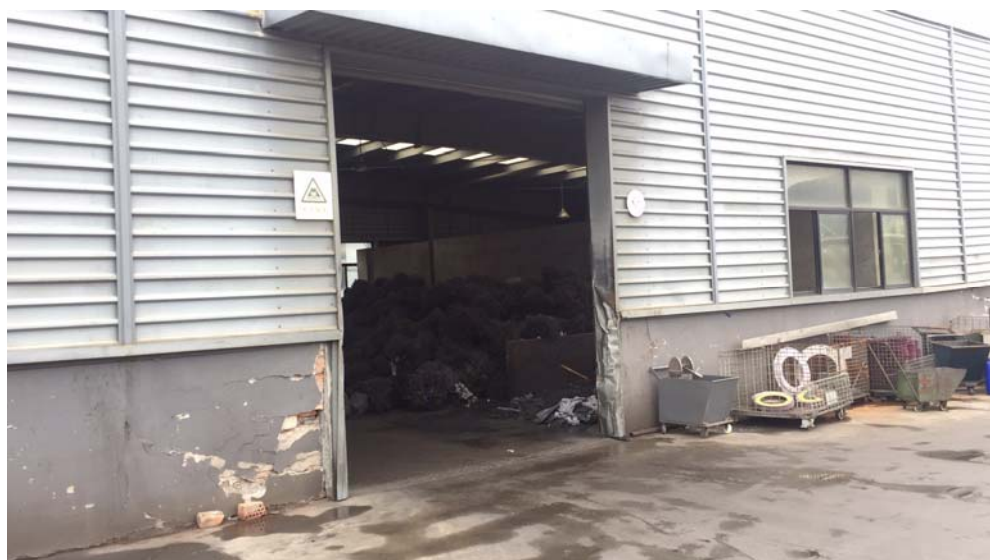
附件四：一般固废堆场
